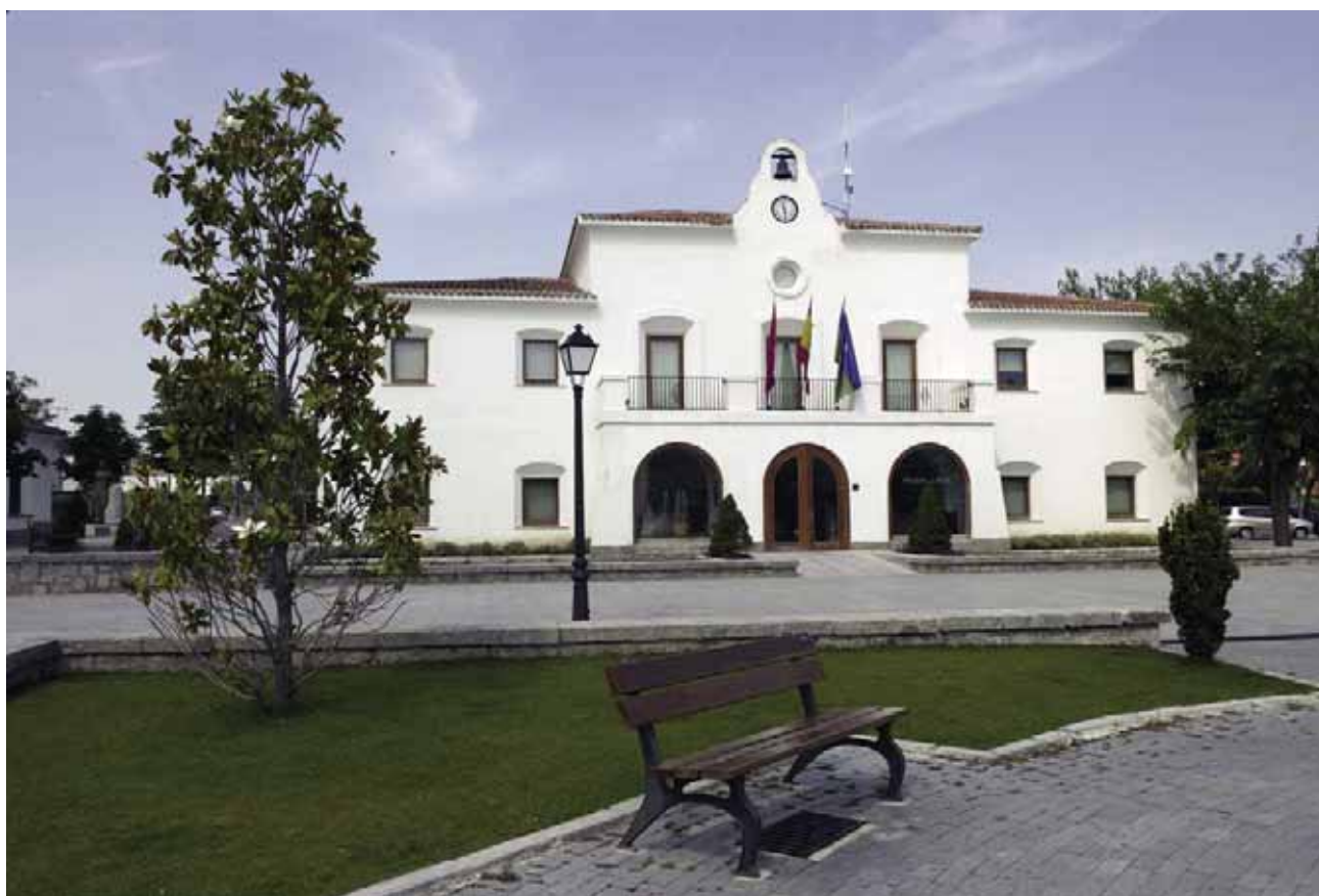
Durante este año, se llevará a cabo la remodelación de la planta baja del antiguo Ayuntamiento.
