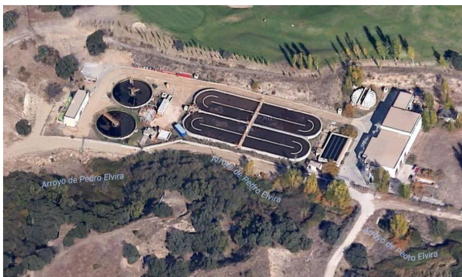
Figura 13. Estación depuradora de aguas residuales, al oeste de la avenida de España.
